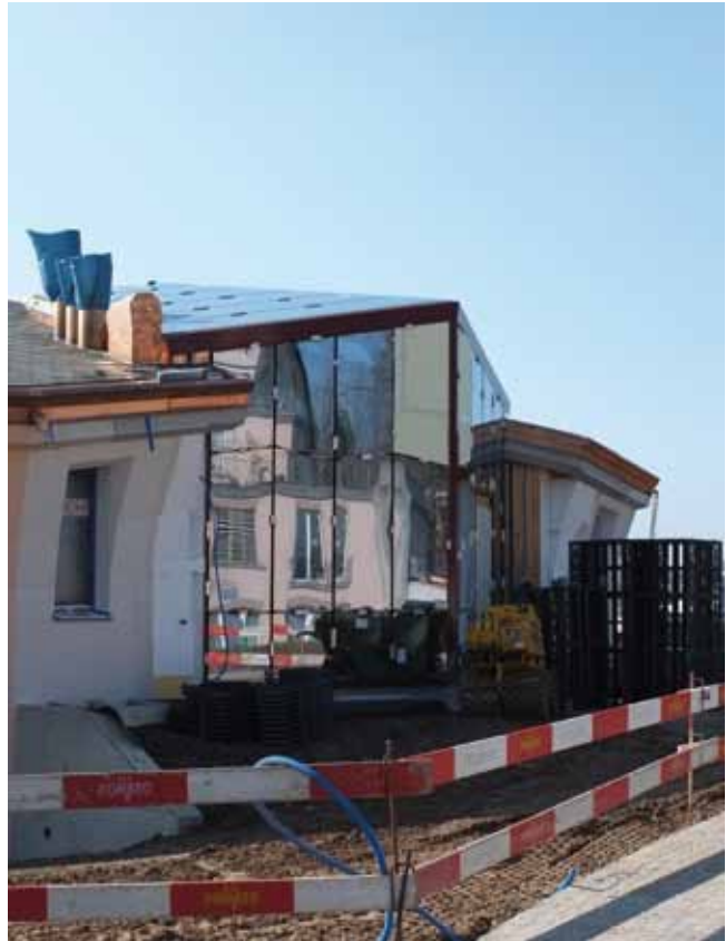
Letzte Bauarbeiten am Nordtrakt
