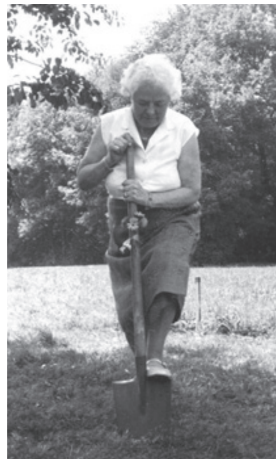
Alice Huber eröffnet das Baugeschehen Sonnengarten mit dem 1. Spatenstich
