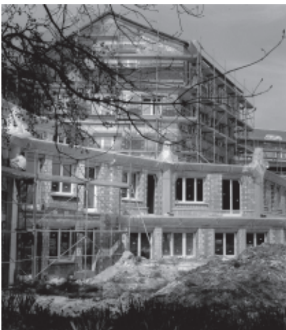
Der Sonnengarten im Bau vor 30 Jahren
