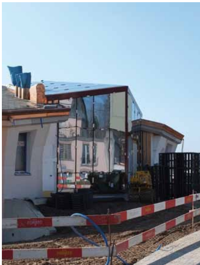
Letzte Bauarbeiten am Nordtrakt
