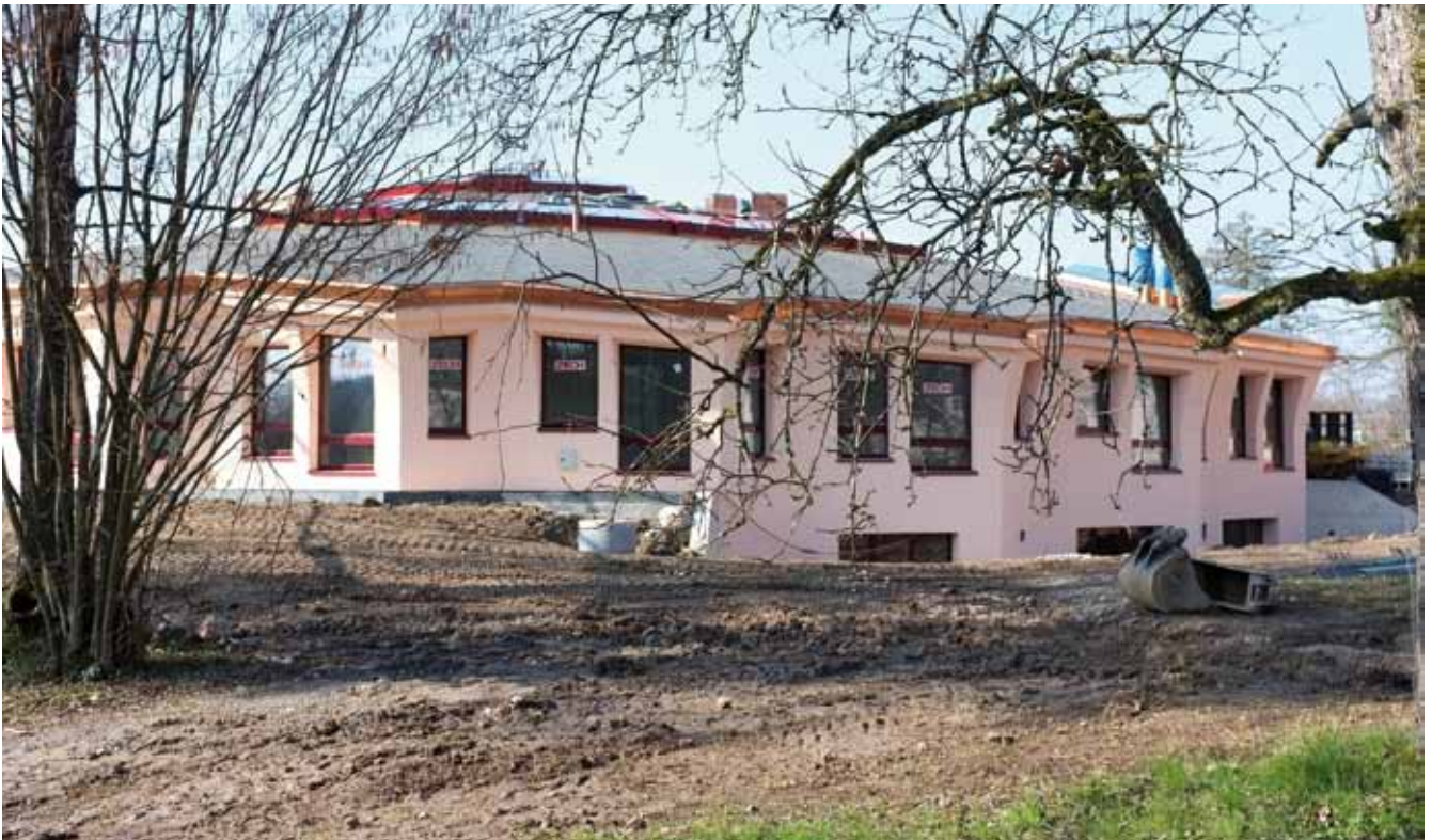
Die fertige Fassade kommt zum Vorschein
