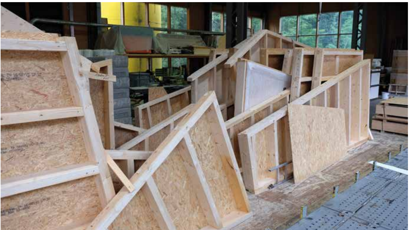
Die Holzbauelemente in der Fabrikation
