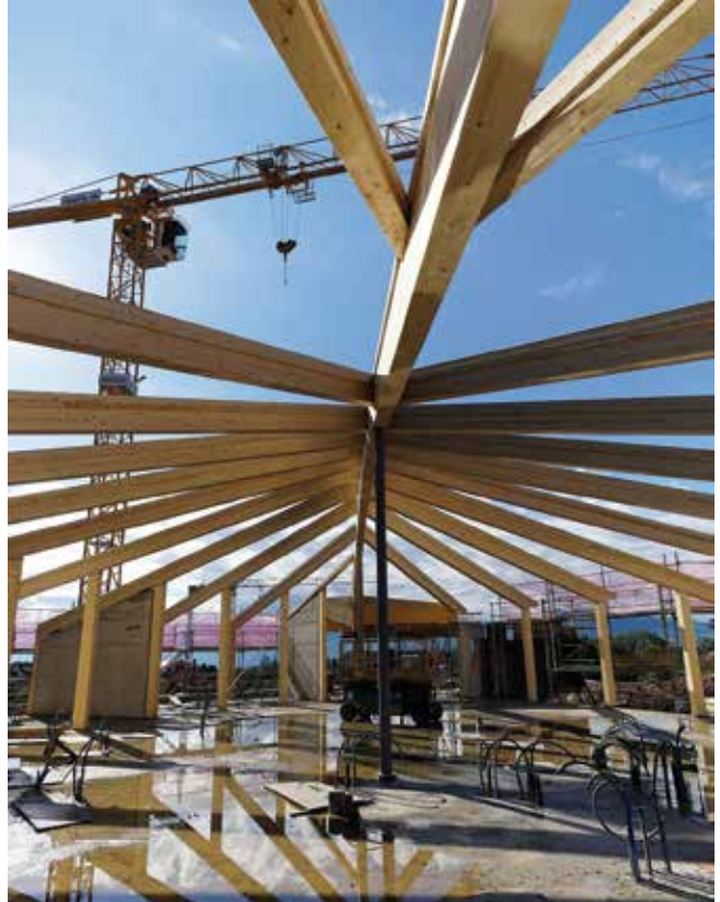
Das komplette Holzträgergestell des Nordtraktes ist aufgerichtet
